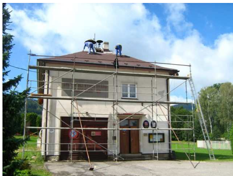
Výměna střešní krytiny na budově obecního úřadu
