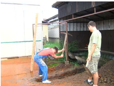
Prováděné práce na odvodnění tenisových kurtů.
