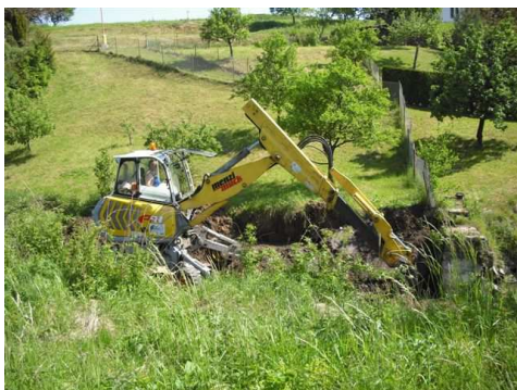
Oprava nádrže na Brusnickém potoce Foto: H. Veverková
