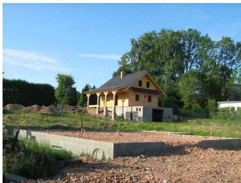
Pokračující výstavba v bývalém parku
