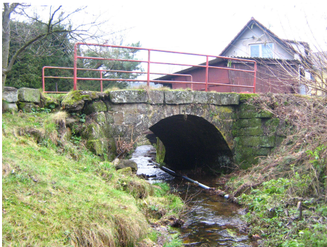
Oprava mostu u Králů.
