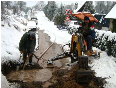
Oprava poruchy vodovodu.
